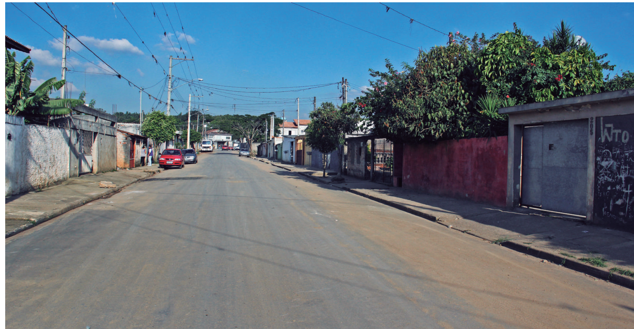
Obras executadas no Jardim Aeroporto II e Jardim Santos Dumont III levaram pavimentação e saneamento básico a avenidas como a Austrália (acima)
