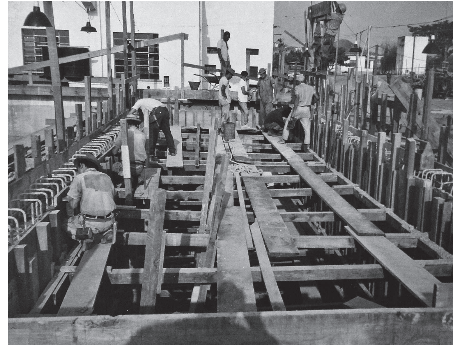
Montagem de estrutura durante reforma e ampliação da primeira Estação de Captação de Água (1970)
