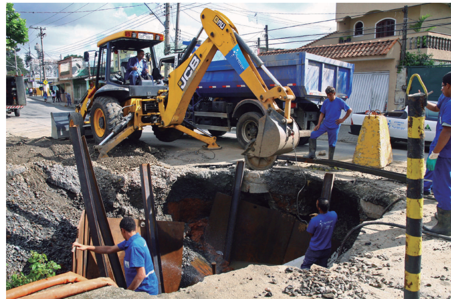
Renovação da frota e melhoria dos equipamentos facilitam as manutenções nas redes de água - um trabalho constante realizado pelas equipes de rua do Sema
