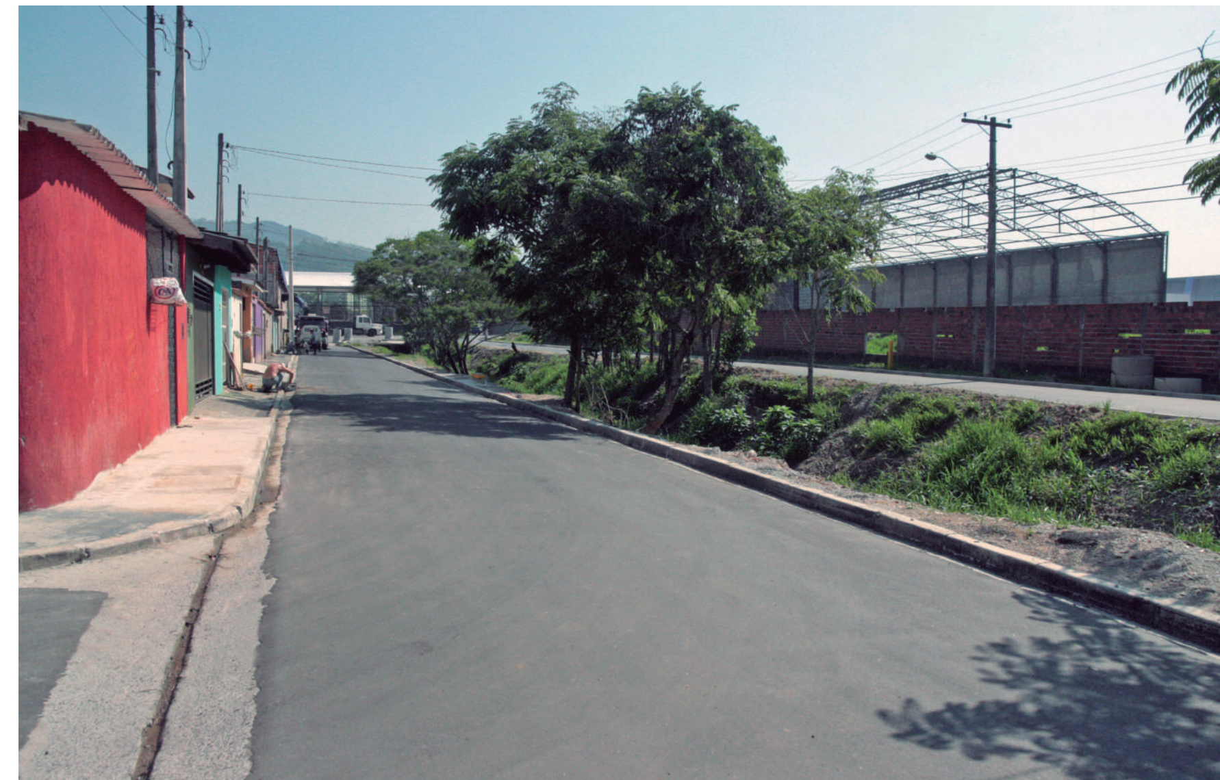
Ruas Projetadas do Rodeio, localizadas às margens da Perimetral, também receberam sistema de esgoto e pavimentação (2012)
