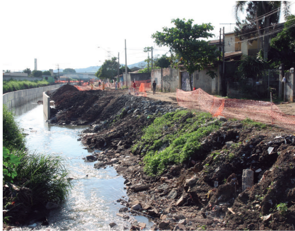
Construção das paredes laterais do Córrego dos Canudos, em 2011: obra começava a mostrar como ficaria o curso d'água
