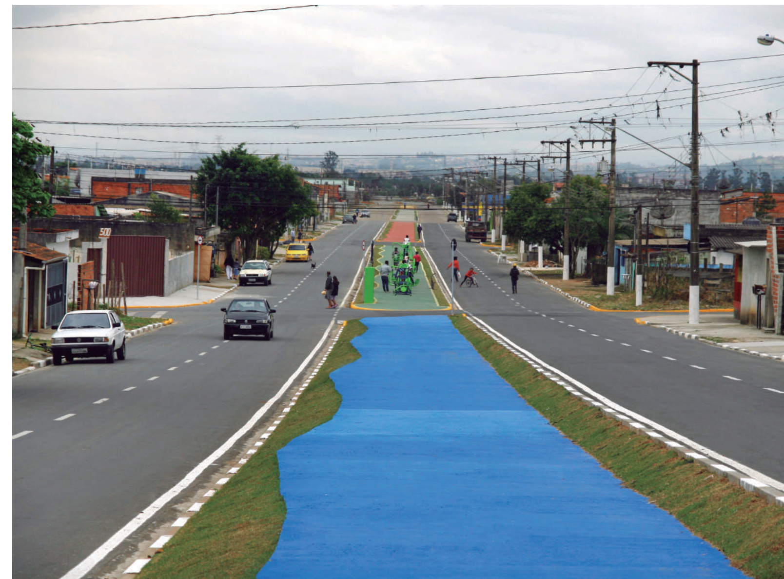
Avenida Dr. Pantaleão Trandafilov Filho, no Jardim Aeroporto II, antes e depois das obras de urbanização, concluídas em 2013
