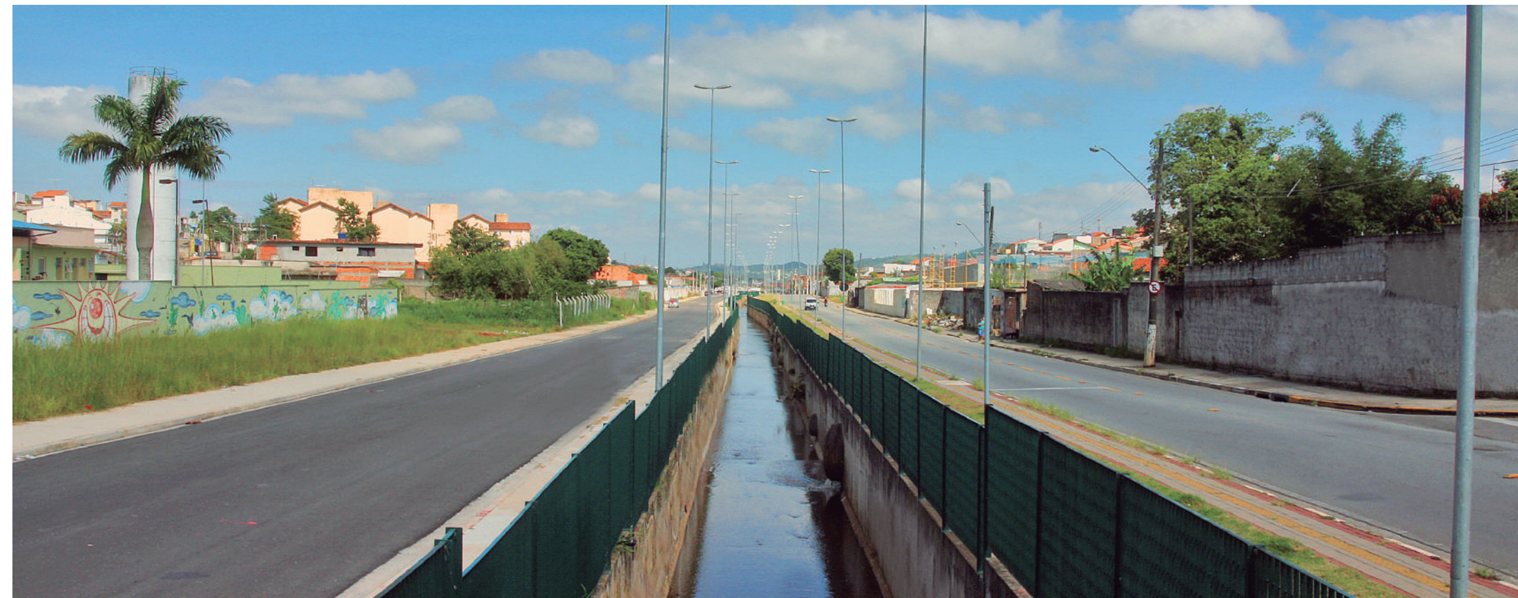
Córrego dos Canudos entre o Jardim Esperança e o Jardim Universo: antes das obras (à esquerda) e na fase final da Avenida Julio Simões
