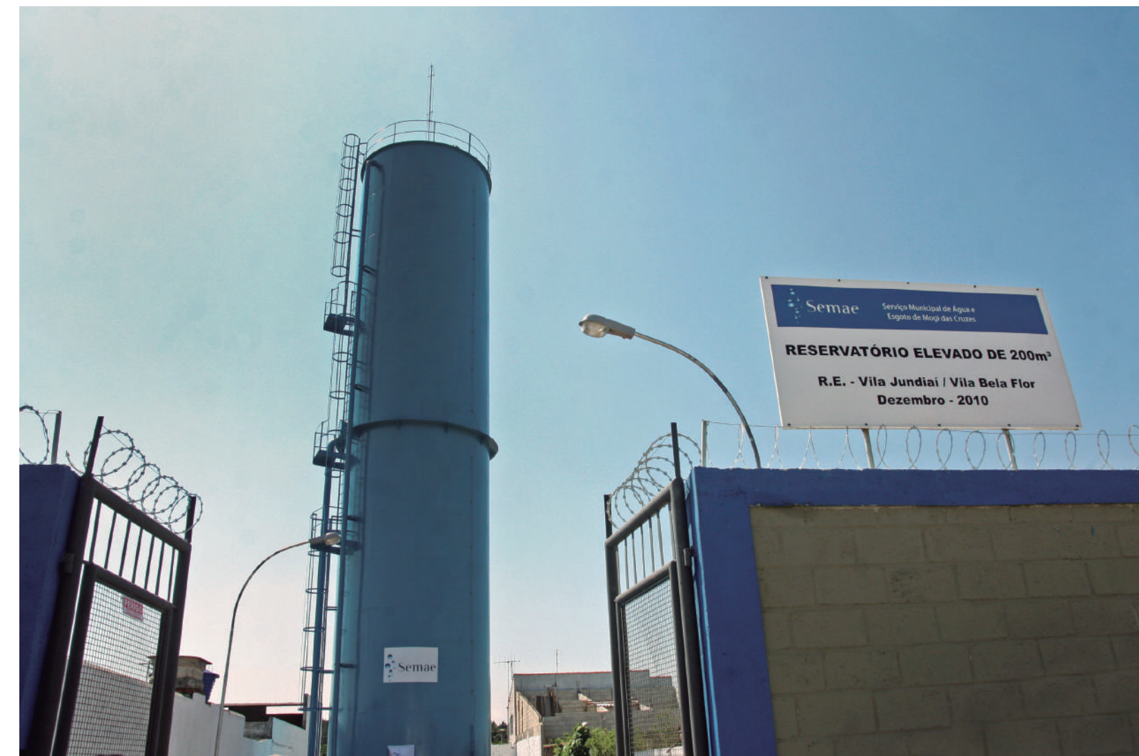
Reservatórios da Vila Pomar (à esquerda) e da Vila Jundiá (acima) ampliam sistema de abastecimento nos bairros
