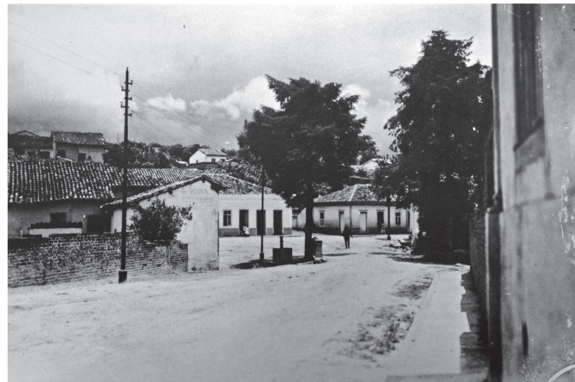
Rua Capitão Paulino Freire, nas proximidades da Rua Ipiranga, em 1922. Embaixo da árvore, nota-se o chafariz, em que a população tinha acesso a água
