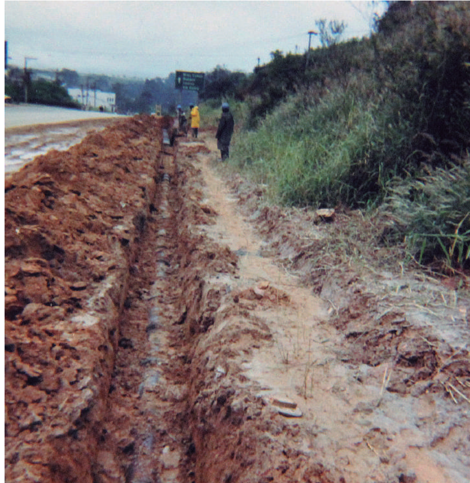
Obra de coleta de esgoto, na década de 1980
