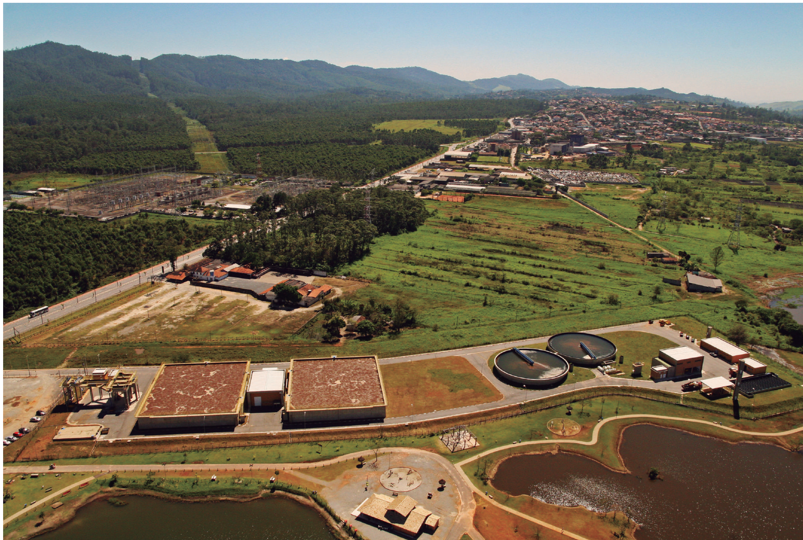
Com a Estação de Tratamento construída em Cezar de Souza, a área leste da cidade passou a contar com sistema próprio de tratamento de esgoto, incluindo demandas futuras que viriam com o crescimento populacional e econômico de Mogi das Cruzes
