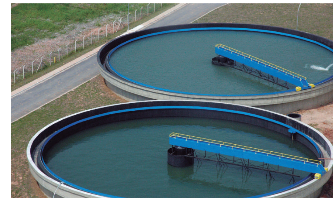
Estação de Tratamento de Esgoto é o marco inicial de uma nova etapa de compromisso ambiental do Sema. Pela primeira vez na história, Mogi das Cruzes possui um sistema próprio para tratamento de efluentes
