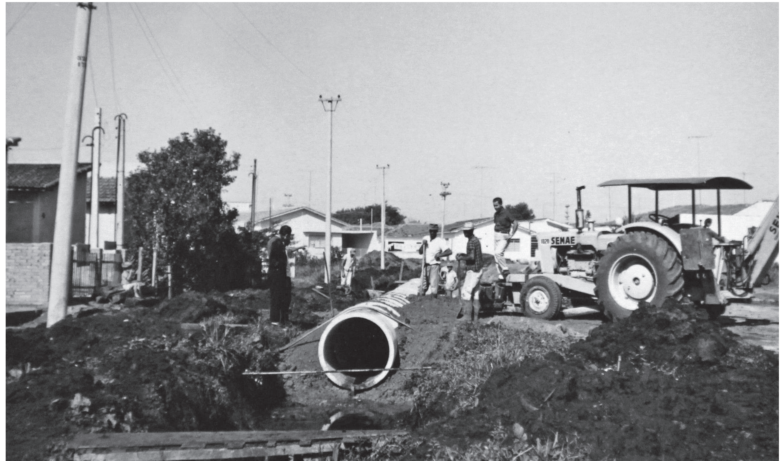
Obra de coleta de esgoto nos primeiros anos do Sema
