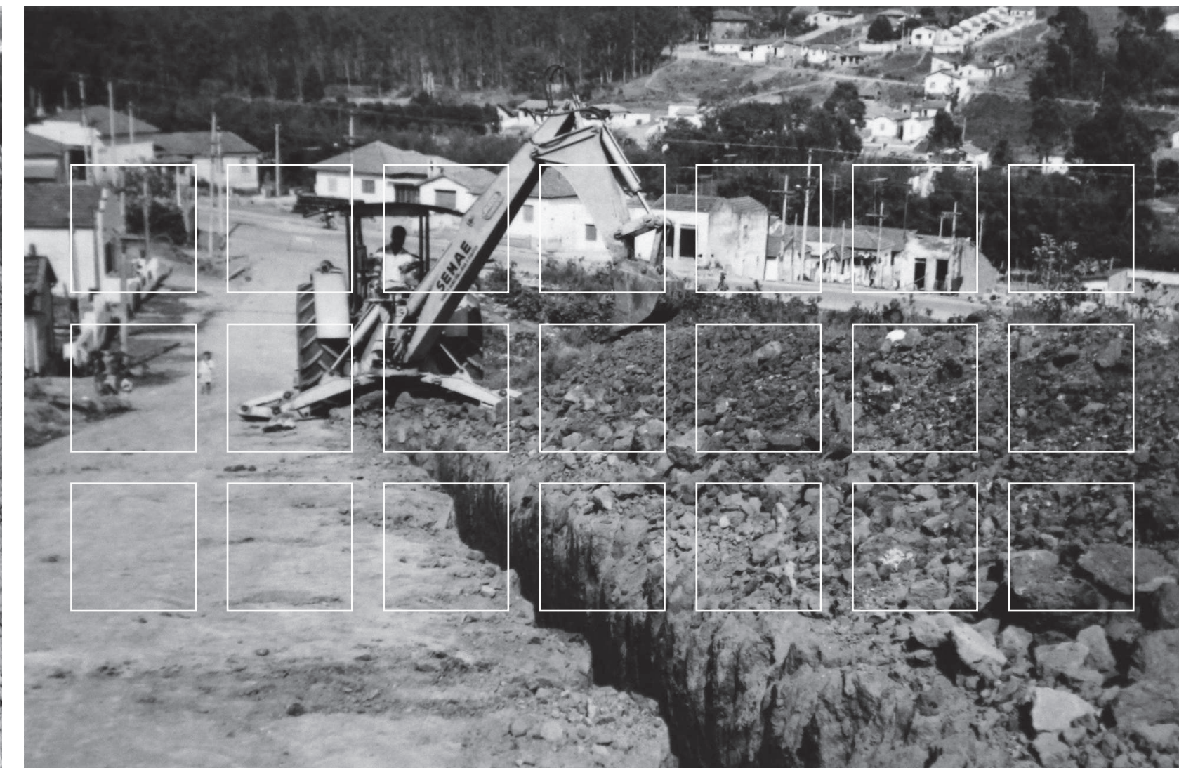
Obras de coleta de esgoto nos primeiros anos do Semae
