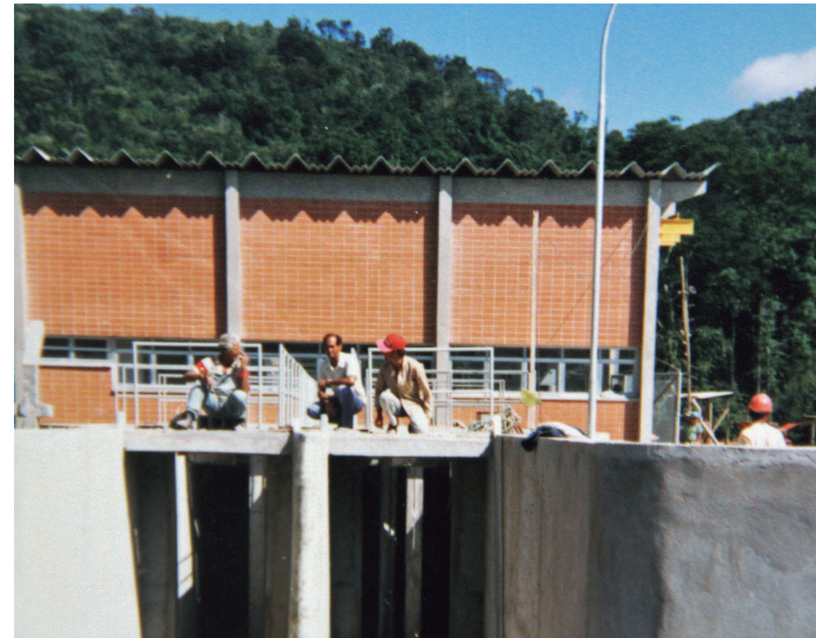
Construção da Estação de Captação e Recalque 2 (ECR-2), que em 1988 permitiu a transferência da captação de água do Rio Tietê do Socorro para o Cocuera
