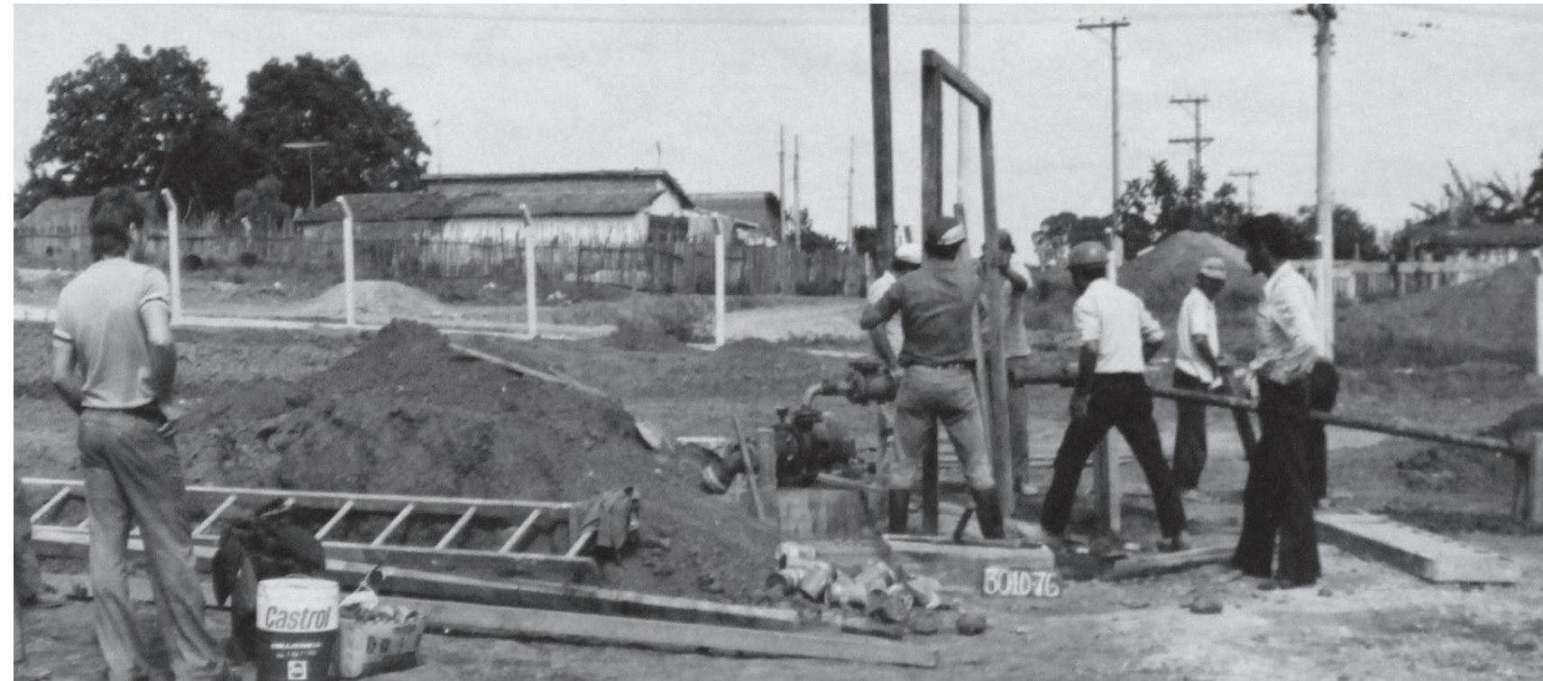
Construção do Reservatório Baixo 2 (RB-2), no Jardim Santa Tereza (1976)
