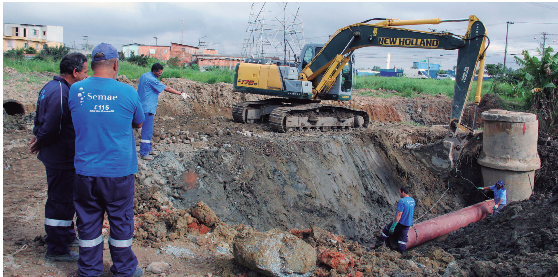
Obra de esgotamento sanitário nas proximidades do Rio Jundiá, entre Braz Cubas e Jundiapéba
