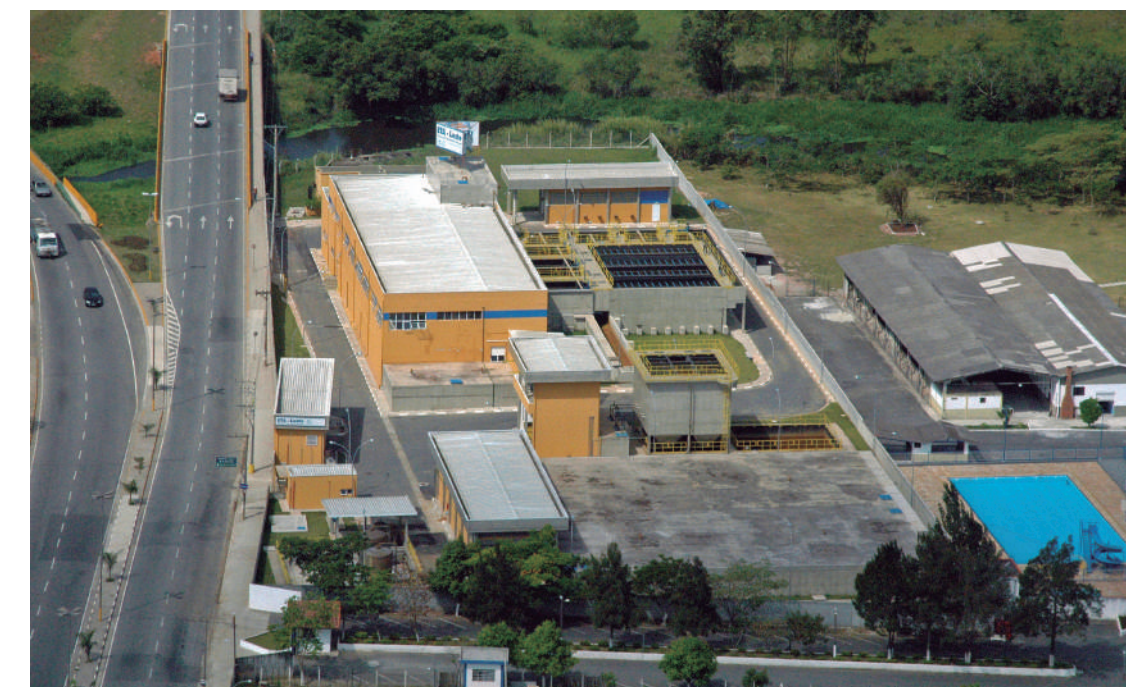
Projeto Mogi-Sanear permitiu ao SemaE construir sua segunda - e mais moderna - Estação de Tratamento de Água, na Avenida João XXIII, onde também funcionou a primeira captação de água no Rio Tietê
