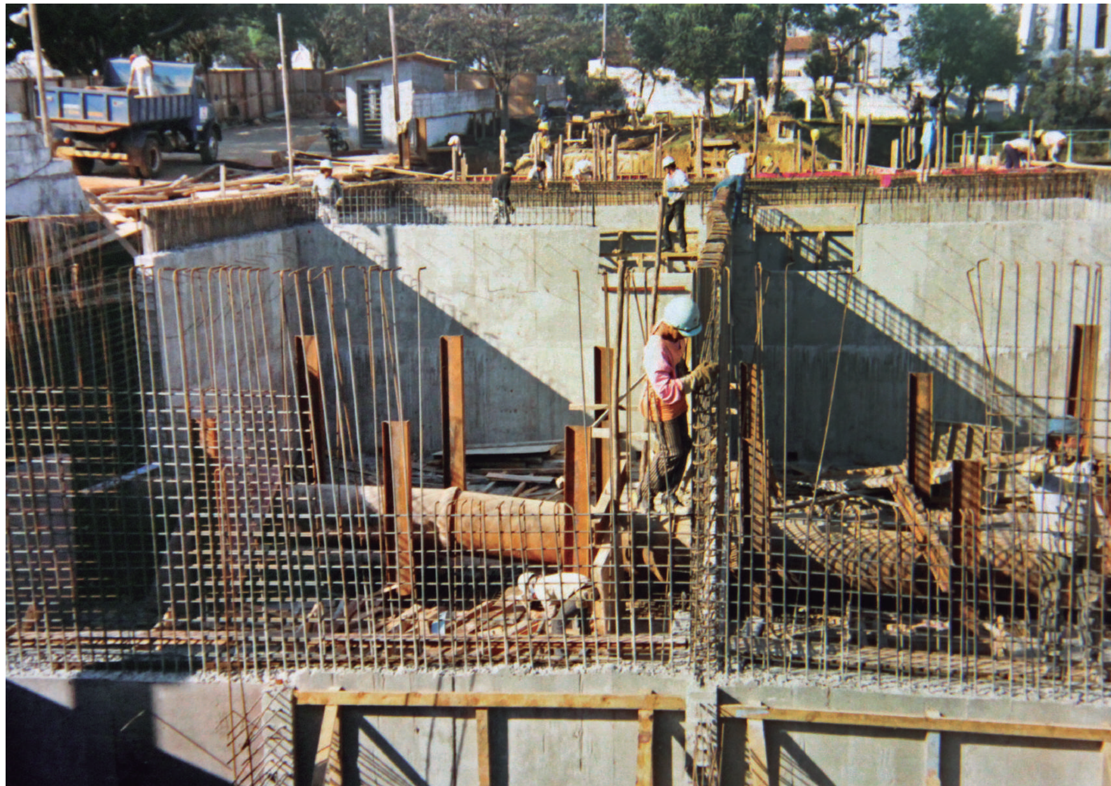
Construção dos novos floculadores usados no tratamento da água (início dos anos 90)
