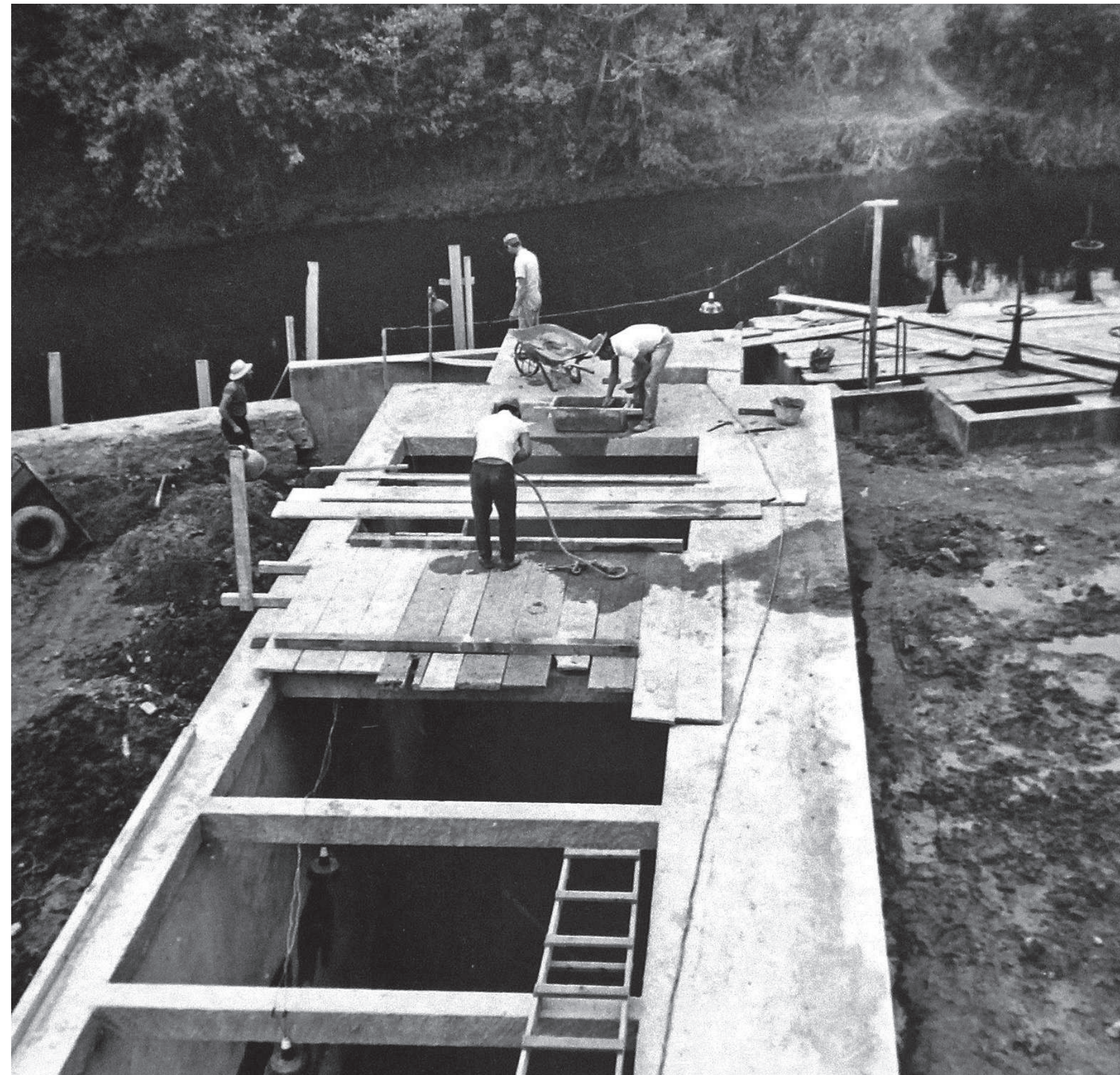
Operários trabalham na reforma e ampliação da primeira Estação de Captação de Água, às margens do Rio Tietê (1970)
