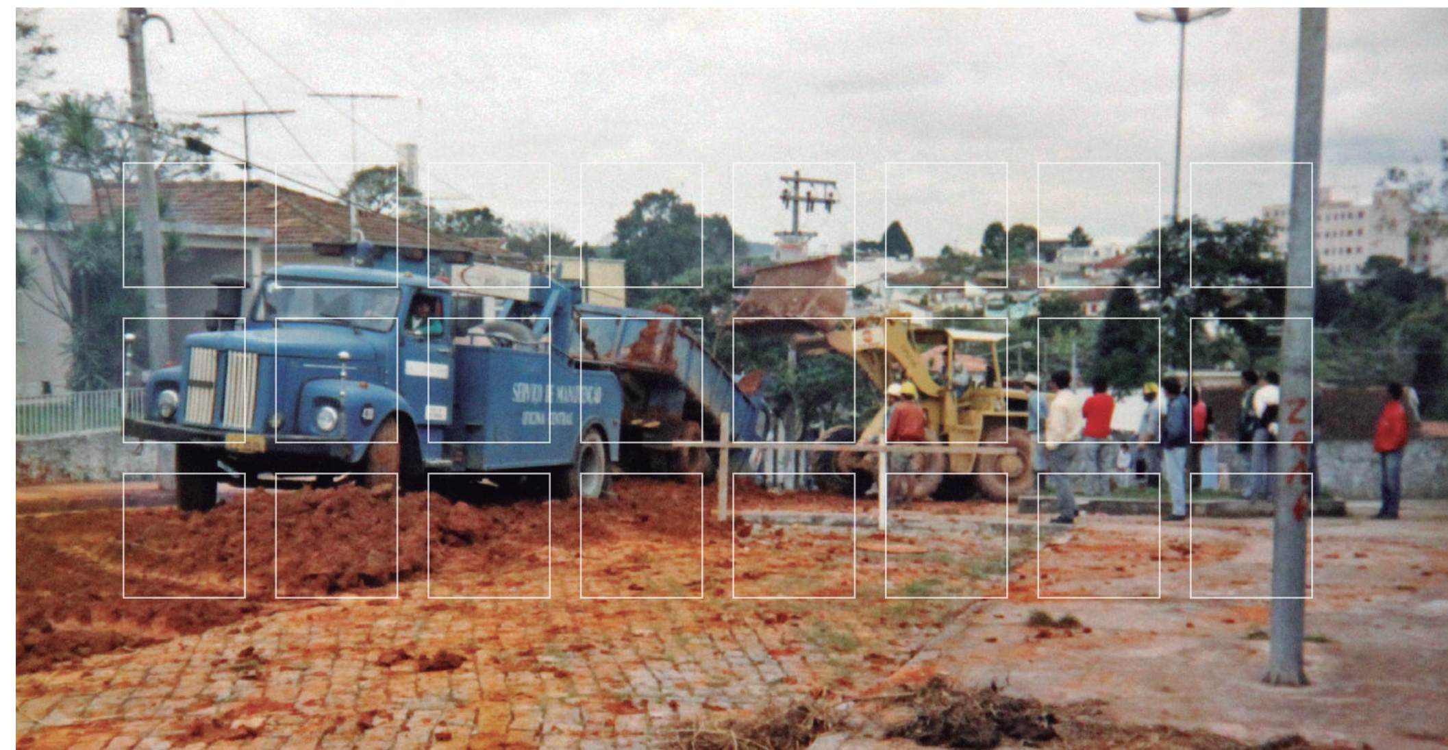
Abaixo e à esquerda, construção de adutora entre a ETA Centro e o reservatório da Vila Natal (início dos anos 1990)
