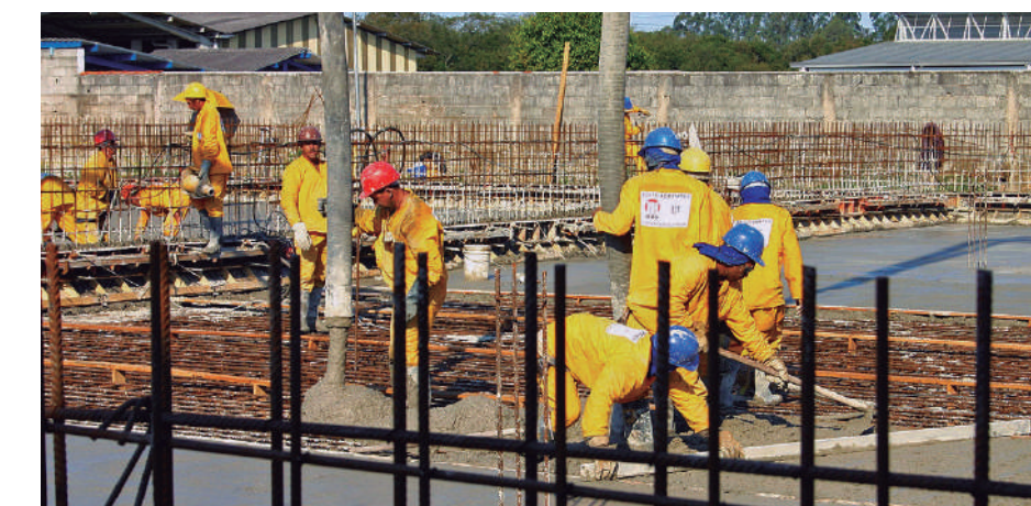
Acima, operários trabalham na concretagem da base da ETA Leste; Projeto Mogi-Sanear começava a ganhar forma
