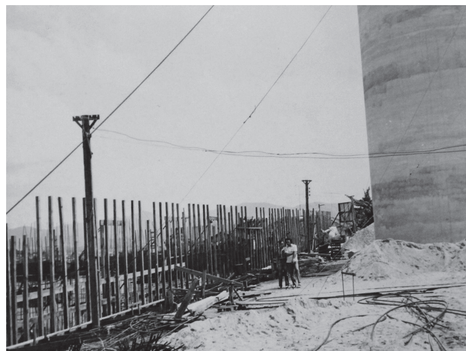
Construção dos reservatórios (baixo e elevado) da Vila Natal, em fotografias de 1972
