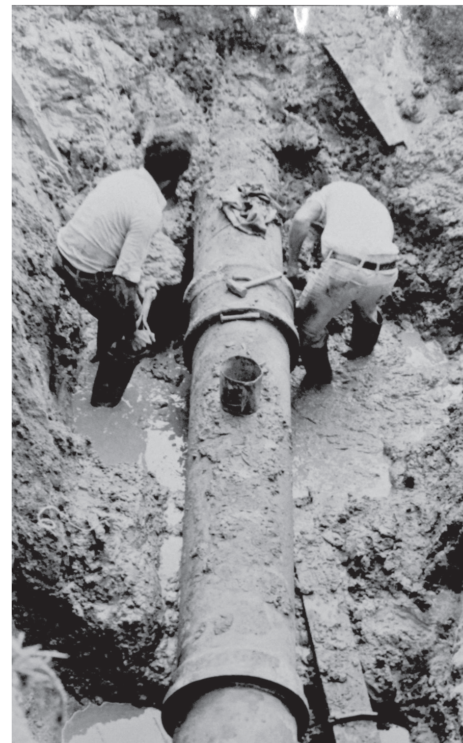
Implantação da tubulação que levava a água do Rio Tietê à Estação de Tratamento, na década de 1950
