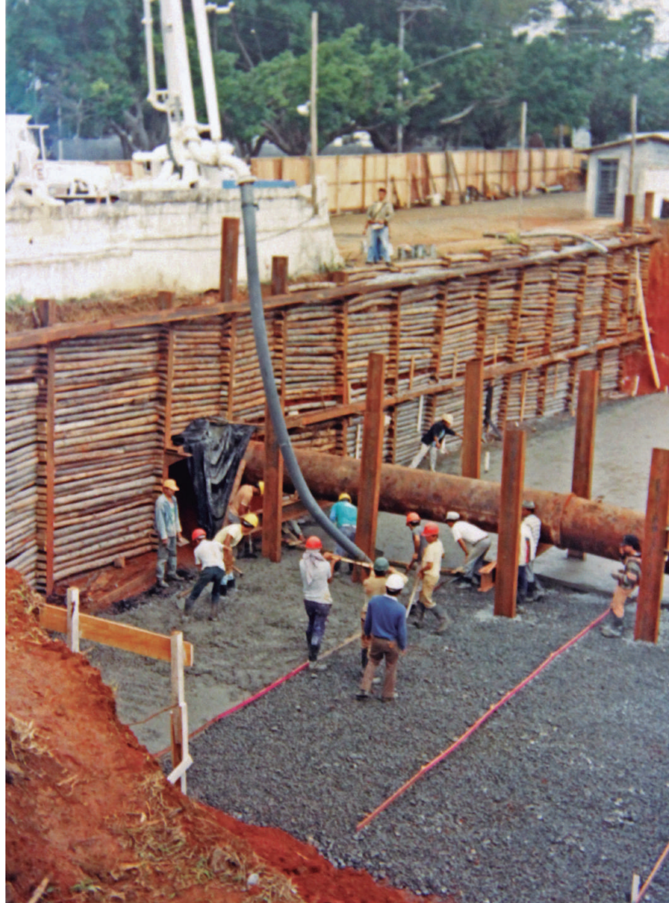
Concluídas as escavações, operários trabalham na estrutura dos novos floculadores da ETA Centro (início da década de 1990). A tubulação é da chegada de água bruta, vinda da Estação Pedra de Afiar, no Cocuera
