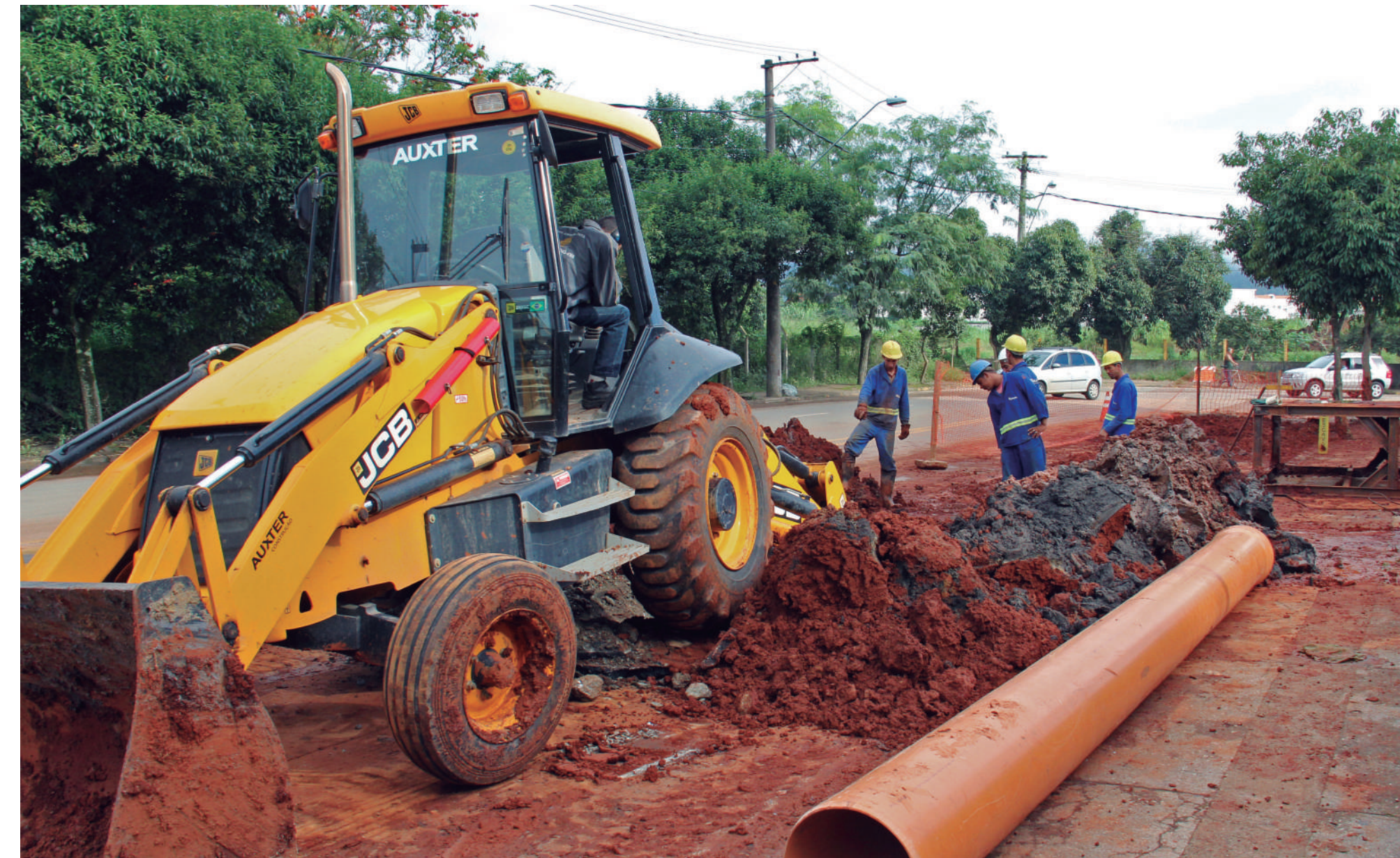
Ampliação de redes de esgoto no Distrito de Cezar de Souza
