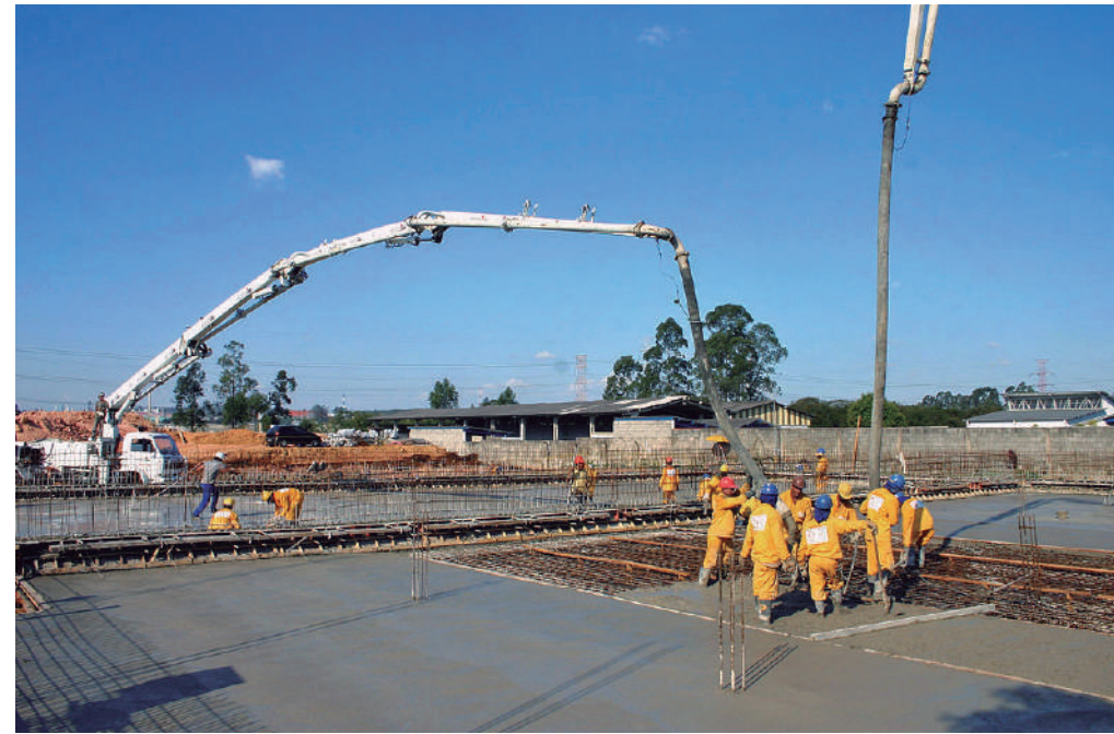
Na sequência acima, trabalho de concretagem das lajes da ETA Leste, em 2005
