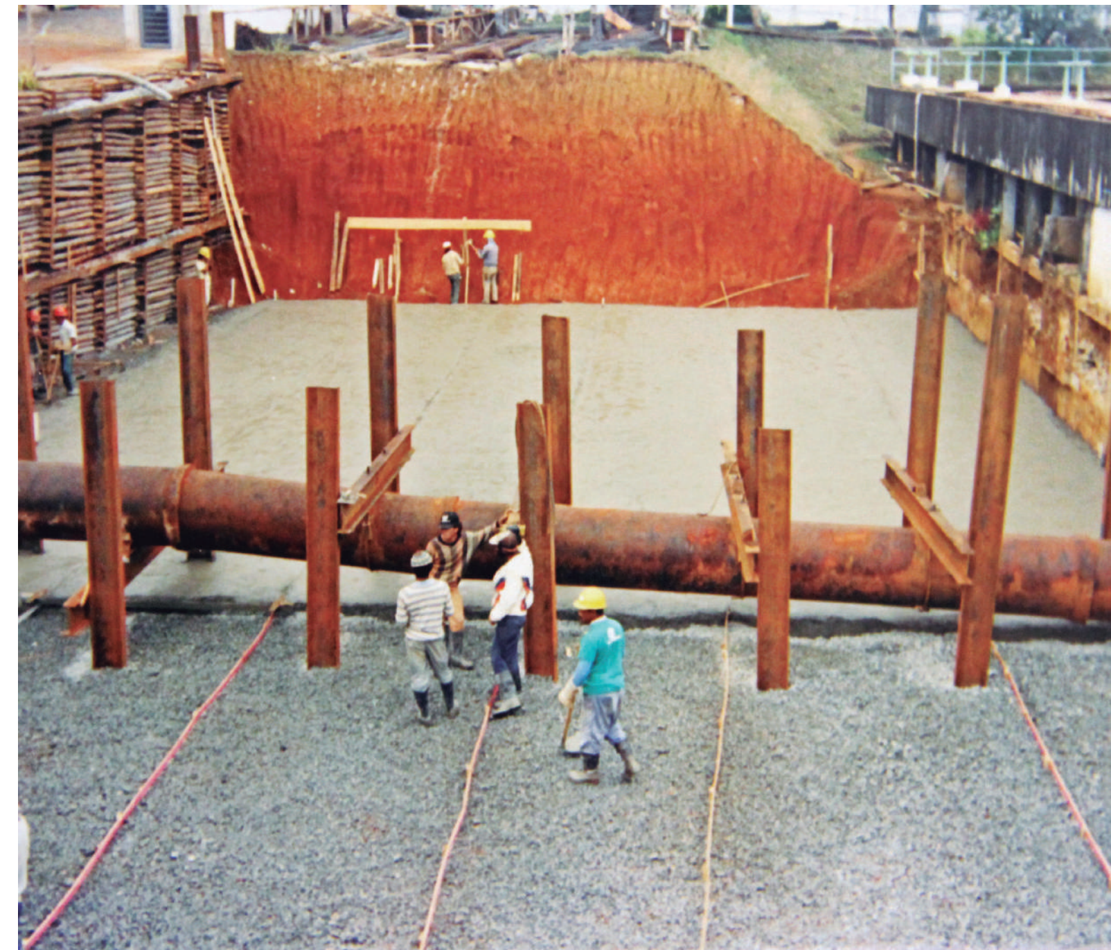
Concluídas as escavações, operários trabalham na estrutura dos novos floculadores da ETA Centro (início da década de 1990). A tubulação é da chegada de água bruta, vinda da Estação Pedra de Afiar, no Cocuera
